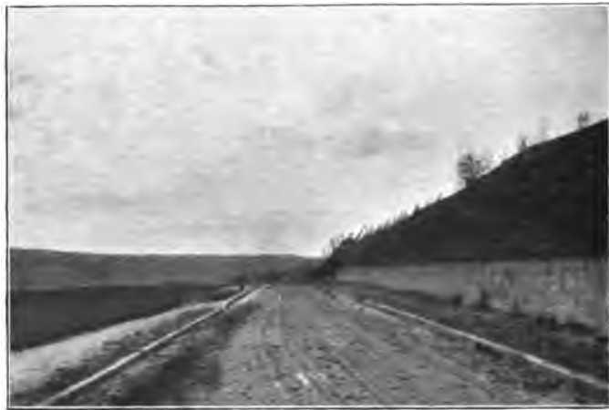
29. 30. Stuttgart, Weinbergsweg vor und nach dem Ausbau der Strasse
