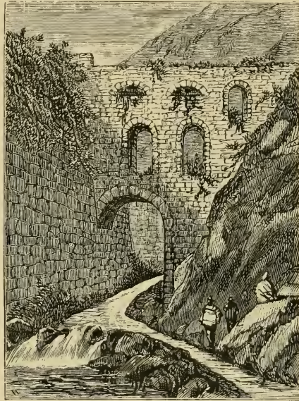
AQUEDUCT OVER THE RODADERO.
